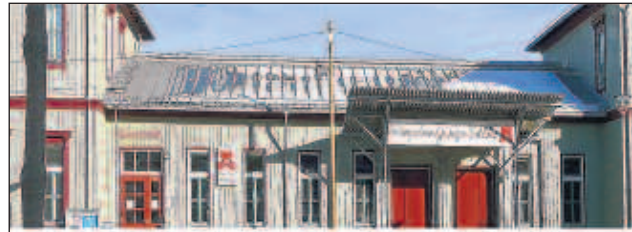
Kulturzentrum Giesinger Bahnhof
